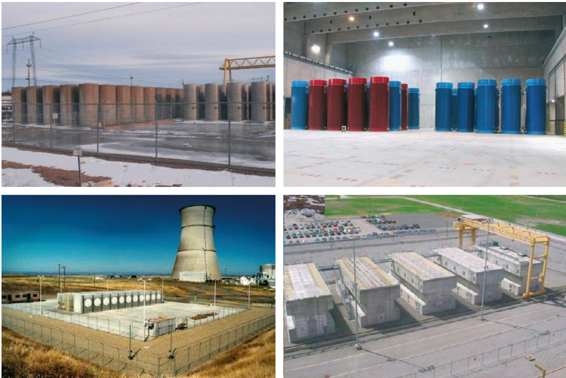
Figur 9-2. Exempel på anläggningar för torr lagring. Överst till vänster Utomhuslagring vid Point Lepreau Generating Station (Källa: NBPower Nuclear). Överst till höger CASTOR®-behållare i lagerbyggnad vid Gorleben i Tyskland (Källa: IAEA). Nederst till vänster NUHOMS® vid Susquehanna kärnkraftverk i USA (Källa: IAEA). Nederst till höger CANSTOR®-moduler vid Gentilly-2 i Kanada (Källa: Hydro Quebec).
