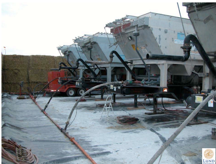
Fig. 12. Kompressoruppställning för luftborrning i Lund Febr. 2003.
